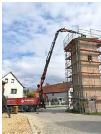
In der darauffolgenden Woche wurde von der Firma Gallhöfer per Hochkran das Dachmaterial geliefert und gleich aufs Dach gehoben. Zwei Kameraden erledigten die Klempnarbeiten, so dass bereits vor dem Wochenende das Dach mit Trapezprofil eingedeckt war. Freitag und Sonnabend war dann Großeinsatz. Mit Hochdruckreinigern haben wir die Wände von Schmutz und losen Putzteilen gereinigt, sowie Putz und Malerarbeiten durchgeführt. Das nächste
