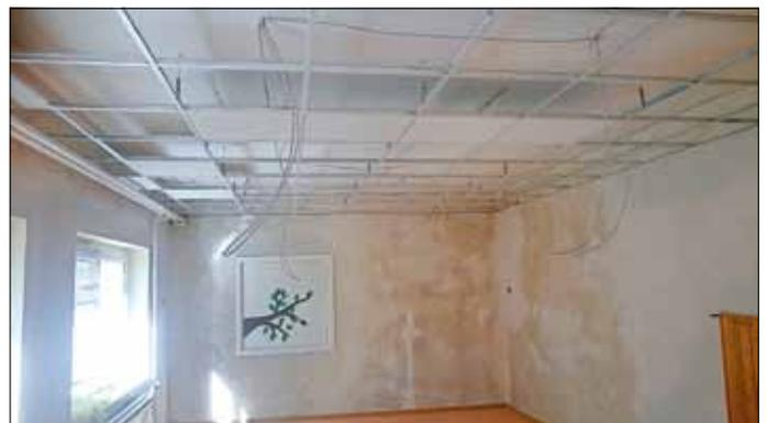
Aus dem gleichen Programm des Freistaats und des Bundes kommen die Mittel zur Erneuerung der Elektrik und des Einbaus von Schallschutzdecken in der Kindertagesstätte Kleinbautzen. Die Arbeiten sollen bis Ende November beendet werden.
