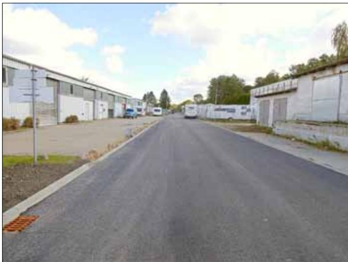
Der grundhafte Ausbau der Haupteinfahrstraße im Gewerbegebiet Niedergurig soll noch in diesem Jahr abgeschlossen werden. Der erste Teil der Schwarzdecke wurde bereits eingebaut und die Arbeiten zur Fertigstellung des Regenwasserkanals haben begonnen. In der ersten Novemberwoche soll dann der Asphalteinbau für den zweiten Abschnitt erfolgen.
