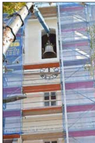
Im Anschluss wurden alle Glocken in den Turm gehoben. Millimeter-Arbeit war das Einheben der großen Glocke. Rechts und links war nur wenig Platz am Fenster. Dennoch kamen die 4 Glocken wohlbehalten in der Glockenstube an.
