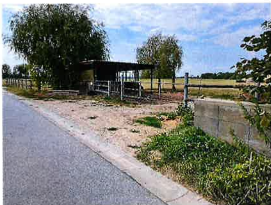
Abb. 1: Plangebiet am Brunnenweg
