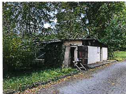
Außenansicht WC Anlage (Jugendclub)
