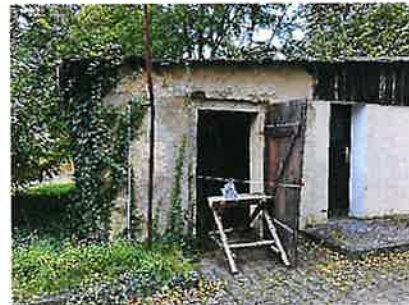
Eingang Lager (WC Anlage)
