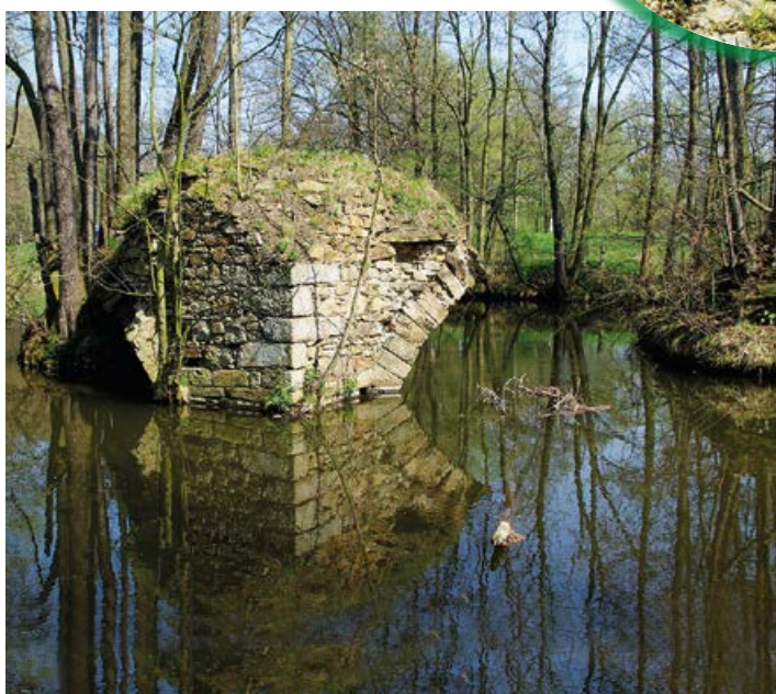
Alter Brückenpfeiler – um 1720 erbaut – zerstört 1804 durch Hochwasser
