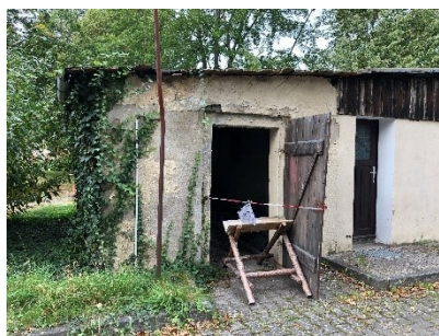
Eingang Lager (WC Anlage)
