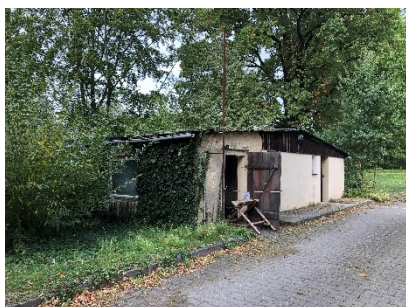
Außenansicht WC Anlage (Jugendclub)
