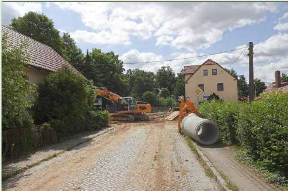
Grundhafter Ausbau der Ortsdurchfahrt Kleinbautzen
