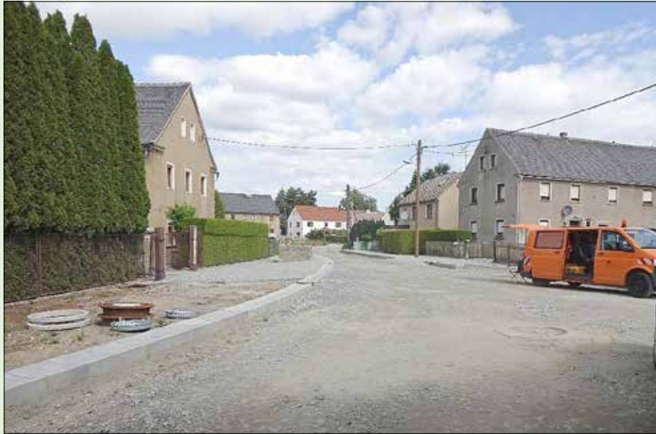
Grundhafter Straßenausbau in Briesing
